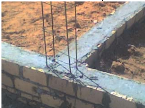
Construcción en mampostería
