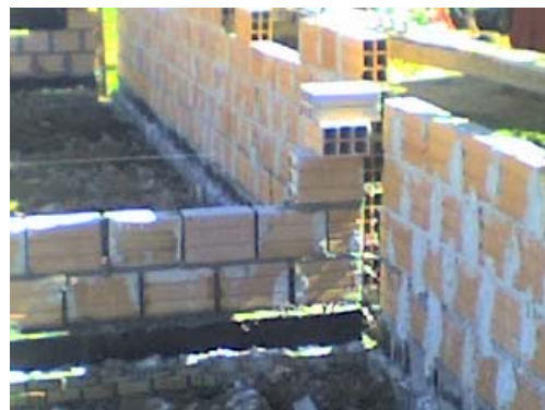
Los muros suben...
