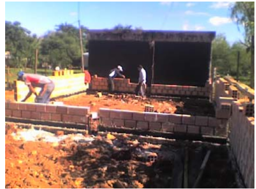
Levantamiento de muros 0.15
