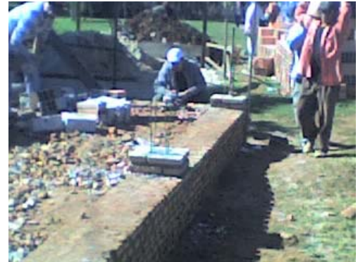
Nivelación de galería
