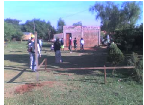
Sitio definido de obra
