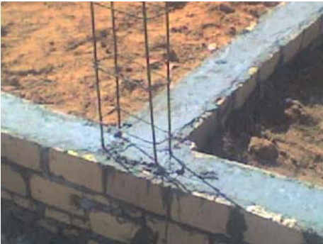
Det. De nivelación y armaduras
