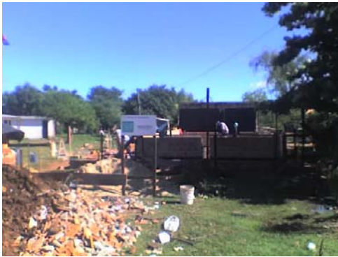
Vista gral de obra
