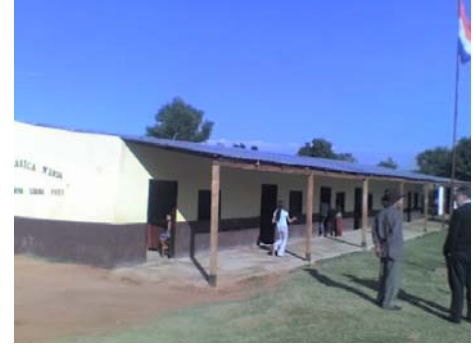
Bloque recientemente restaurado
