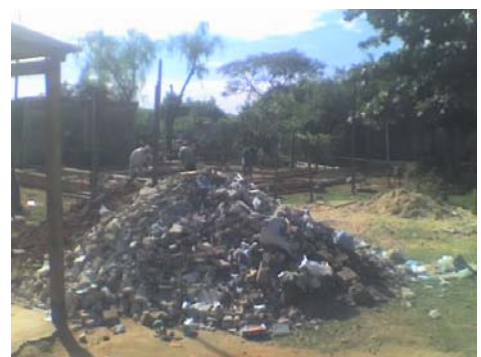
Depurar escombros de basura
