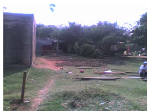
Marcación y desbroce de suelo
