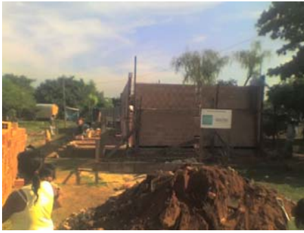
Vista gral de obra
