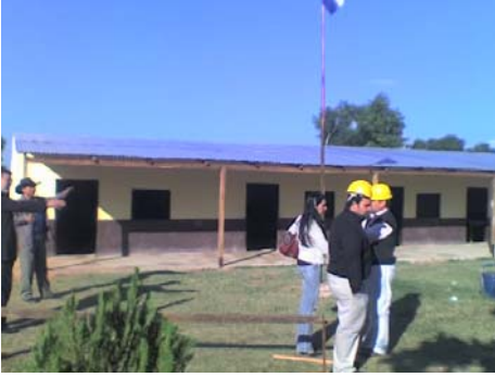
Elección del sitio de obra
