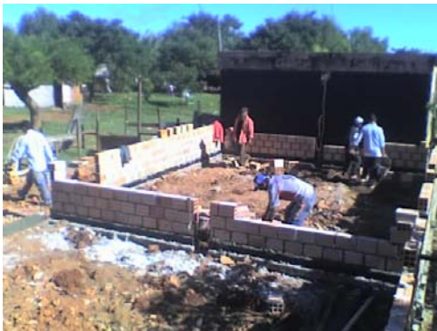
Aislación de muro existente
