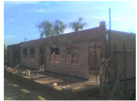
Levantamiento de muros 0.15
