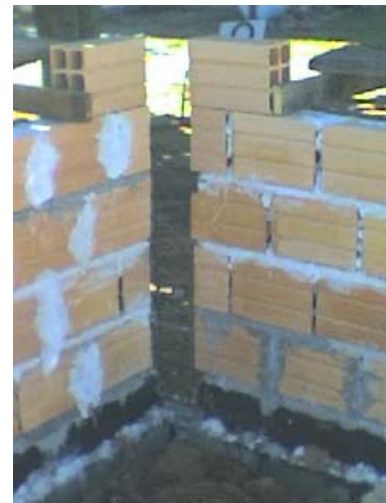
Unión en esquina de muros
