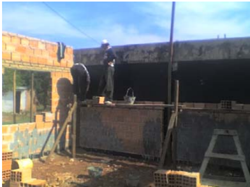
Aislación de muro existente
